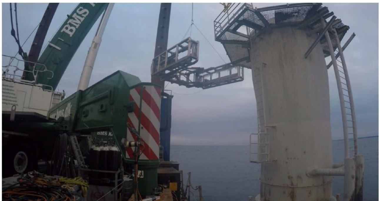
Figure 6-142 Cutting the foundation of YTTRE STENGRUND OWF (Kurdve 2016)
